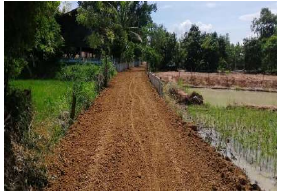
๘. โครงการก่อสร้างถนนดินลงหินลูกรัง หมู่ที่ ๖ บ้านหนองหอย
